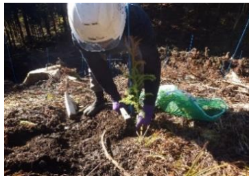
＜伐採後の植栽＞
